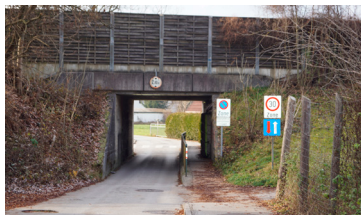
Die derzeitige Bahnunterführung wird verbreitert.
