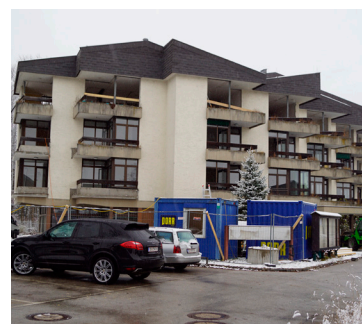
Die Bauarbeiten am alten Seniorenhaus haben begonnen.
